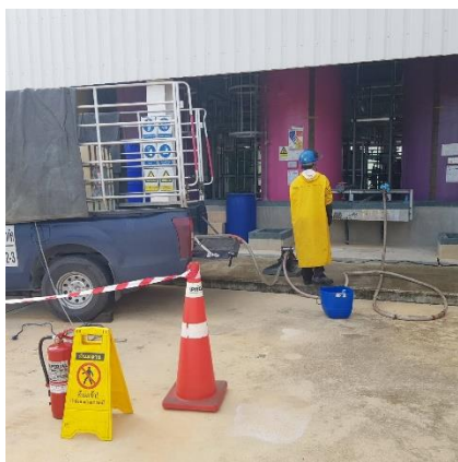
รูปที่ 26 สัญลักษณ์ รหัสแสดงอันตรายของสารเคมี และเครื่องดับเพลิงแบบมือถือ บนรถบรรทุกสารเคมี และการจัดเตรียมเครื่องดับเพลิงแบบมือถือขณะขนถ่ายสารเคมี
