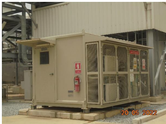
รูปที่ 1 การตรวจวัดคุณภาพอากาศจากปล่องอย่างต่อเนื่อง (CEMs)
